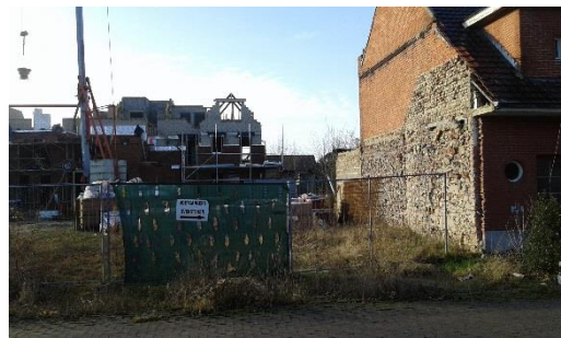
Het groepsbouwproject in aanbouw ten oosten van de aangekochte woning
