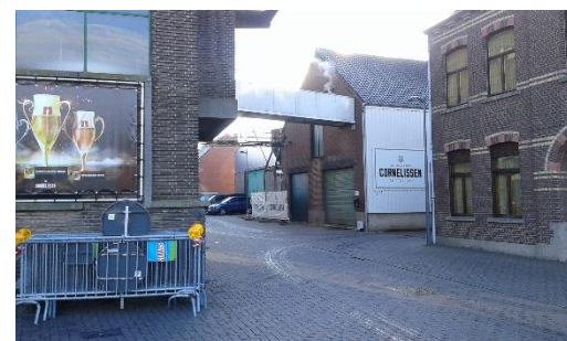
Bedrijfsgebouwen aan Itterplein
