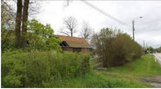
Foto 7 Leegstaande woning langs de N76, binnen het plangebied
