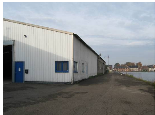
Figuur 4-4: loodsen aan kanaal
