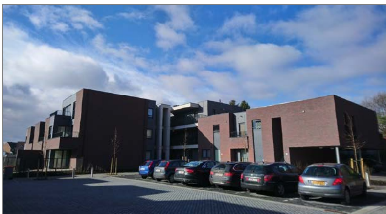
Foto 2: 16 appartementen blok B
