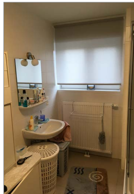
Foto 7: na de renovatie
